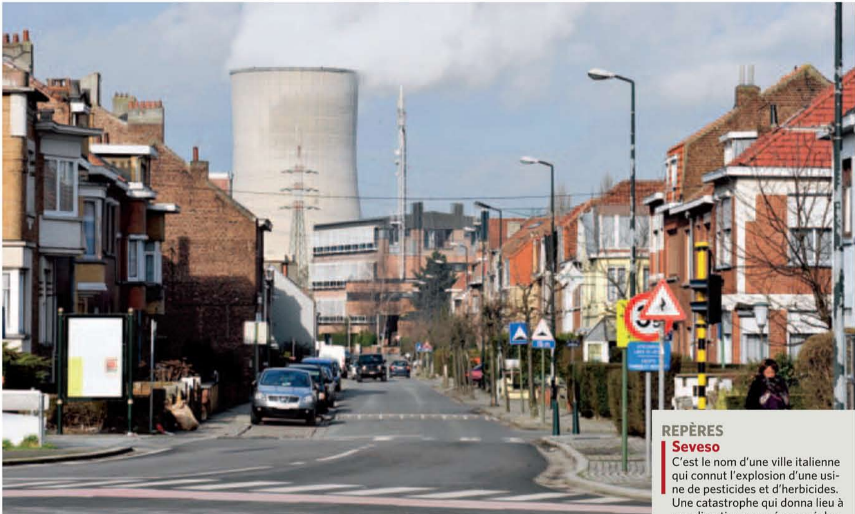
LES RIVERAINS LES PLUS PROCHES DE LA CENTRALE de Drogenbos vivent à moins de 400 mètres du site. © PIERRE-YVES THIENPONT.
